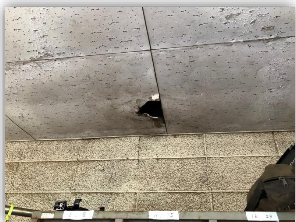
部室天井、穴が開いてしまっています
